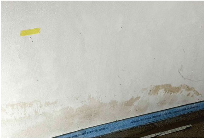
Abb. 08: Kellerwand mit Messpunkten für die Feuchtemessung
