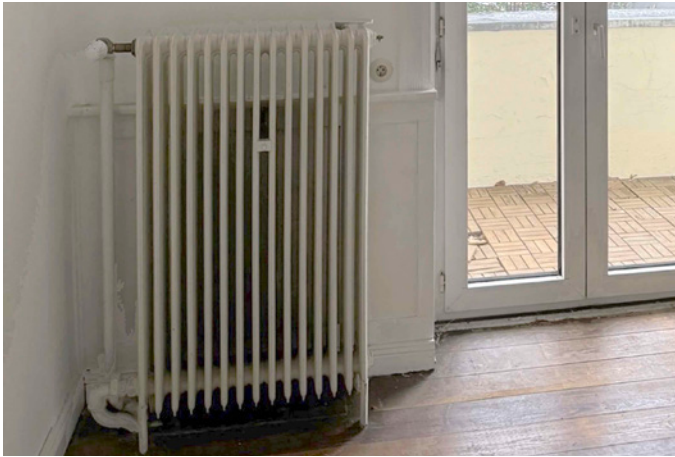
Abb. 03: Bestehender Heizkörper (Gussradiator)
