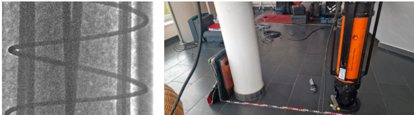
Abb. 12: Visualisierung der Wendel- und Vertikalbewehrung in einer Rundstütze per Radiographie (Röntgen) [Quelle: Dr.-Ing. Sebastian Schulze, bauray GmbH]
