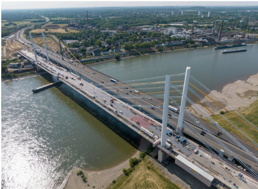
Abb. 02: Brückenbaustelle der Rhein-Brücke Duisburg-Neuenkamp [Foto: Udo Görisch, Take it Media]
