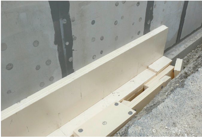
Abb. 02: Punktweise verklebte Perimeterdämmung
