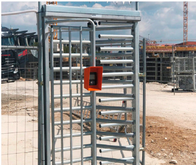
Abb. 02: Modernes Zugangsmanagement: Die Absicherung des Baufelds erfolgt durch ein Drehkreuz, das durch die Baustellencard aktiviert wird. [Foto: Conova24]
