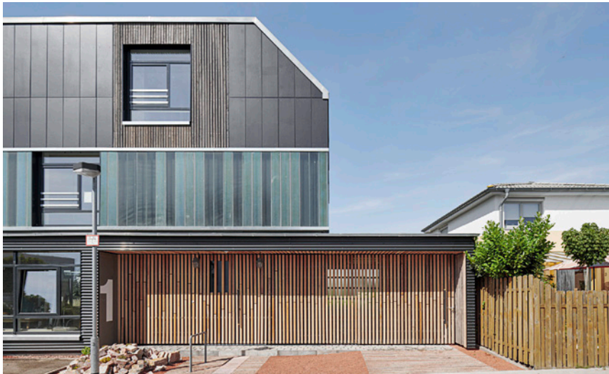
Abb. 02: Fassade aus gebrauchten Bauteilen [Foto: © Olaf Mahlstedt]
