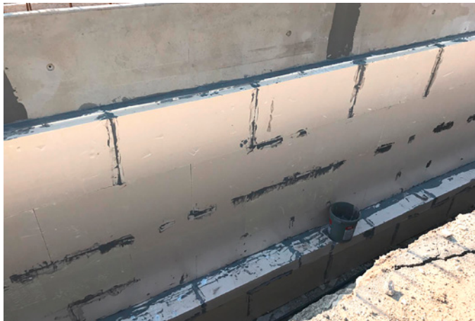
Abb. 06: Neu hergestellte, vollflächige Verklebung der Perimeterdämmung
