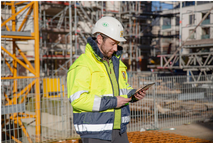
Abb. 01: Überblick in Echtzeit: Die Baustellencard-Software ermöglicht die umfassende Überprüfung der anwesenden Firmen und Mitarbeiter auf dem Tablet. [Foto: Conova24]
