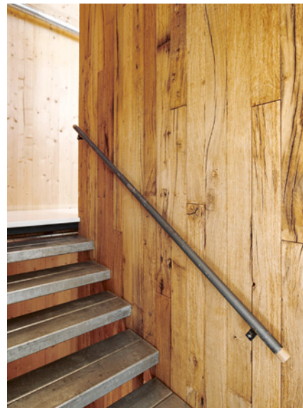
Abb. 05: Wand aus historischen Eichenholzbalken, Treppenkonstruktion aus gebrauchten Stahlteilen [Foto: © Olaf Mahlstedt]
