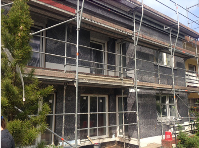
Abb. 02: Energetische Sanierung des Musterhauses [Foto: IFB]
