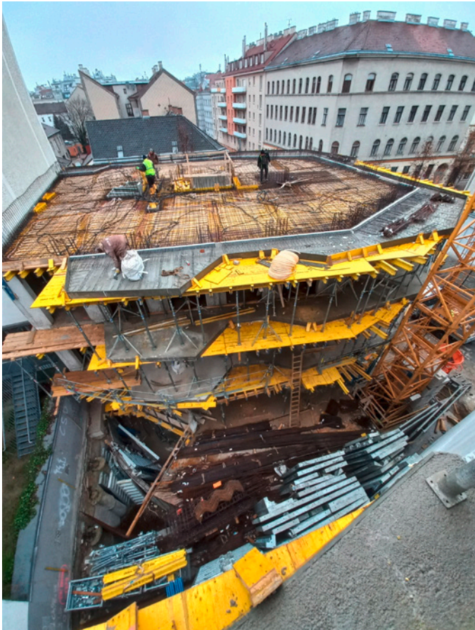
Abb. 04: Verlegung der Bauteilaktivierung im Rohbau [Foto: © zeiningler architekten]
