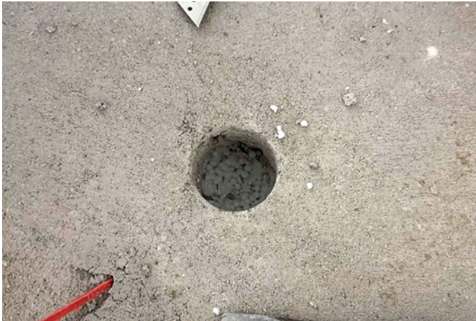
Abb. 04: Bohrung im Fußbodenaufbau für Probenahme
