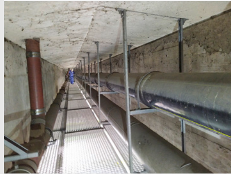
Abb. 04: Wasserleitung DN 200 und Gasleitung DN 300 werden auf Beschädigungen bzw. den Zustand der Rohraflager geprüft. [Foto: Netze BW GmbH]
