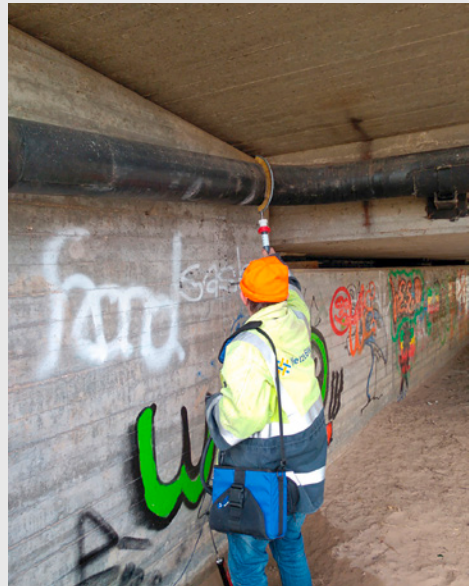
Abb. 05: Prüfung einer Gasleitung DN 200 auf Beschädigungen an der Isolierung mit einem ISO-TEST-Porenprüfgerät [Foto: Netze BW GmbH]
