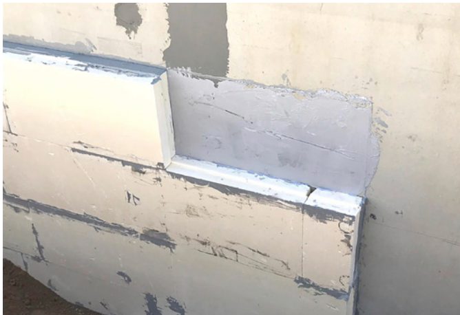
Abb. 04: Vollflächig aufgebrachte Klebermasse auf der Kelleraußenwand
