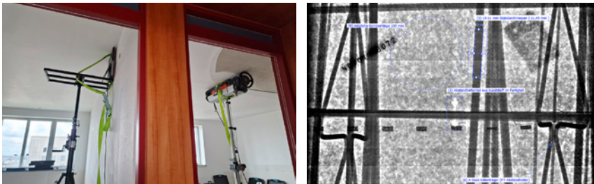
Abb. 05: Untersuchungsaufbau und Röntgenbild einer hochbelasteten Elementwand für das Anlegen von Kernbohrungen ohne Bewehrungstreffer und Fehlbohrungen: Erkennbar sind Bewehrungsstäbe, A-Böcke der Fertigteilschalen sowie Abstandhalter (Kunststoffräder). [Quelle: Dr.-Ing. Sebastian Schulze, bauray GmbH/hupfer ingenieure]
