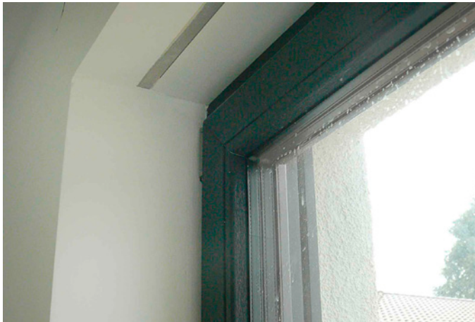
Abb. 01: Neu eingebautes Fenster mit Dreifachverglasung
