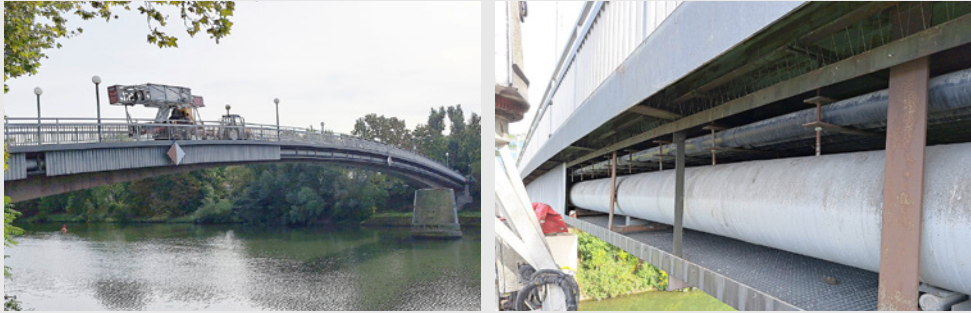
Abb. 02: Mithilfe eines Brückenuntersichtgeräts wurden die Gasleitungen (2x DN 400) auf ihren Zustand geprüft. Hierfür wurde die Blechverkleidung an mehreren Stellen demontiert. Im Zuge dieser Prüfung konnten die Auflager und Rohrteile einer Sichtprüfung unterzogen werden. [Foto: Netze BW GmbH]
