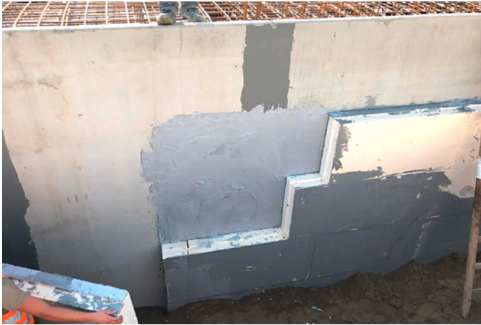
Abb. 05: Ansetzen einer rückseitig mit Klebermasse versehenen Dämmplatte
