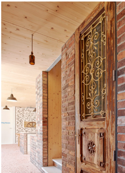
Abb. 04: Innenwände aus Abbruchziegeln [Foto: © Olaf Mahlstedt]
